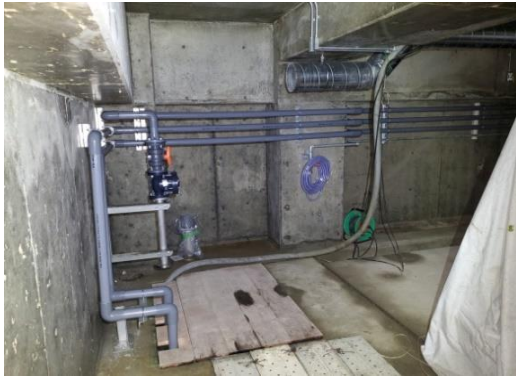
写真⑧ 配管・サポート 敷設
