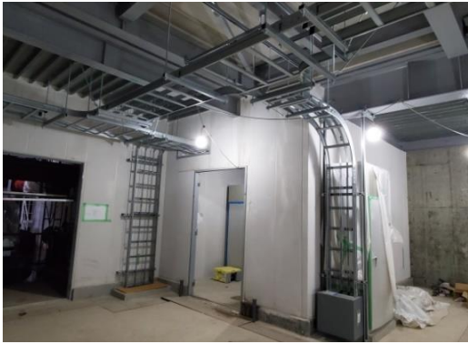
写真⑦ ケーブルラック 敷設
