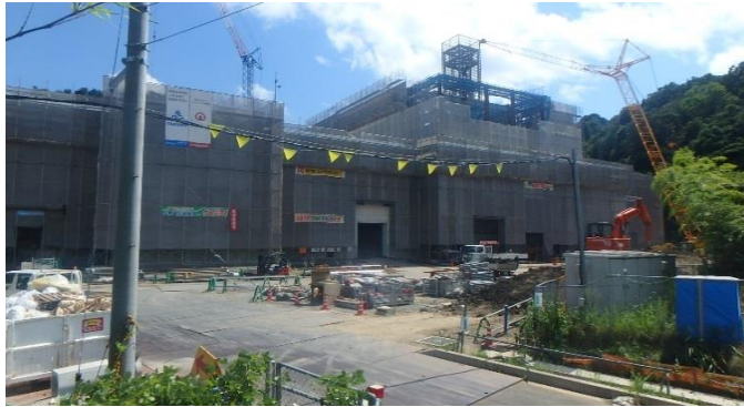
写真⑦ 進入路(現場側)ヤード全景
