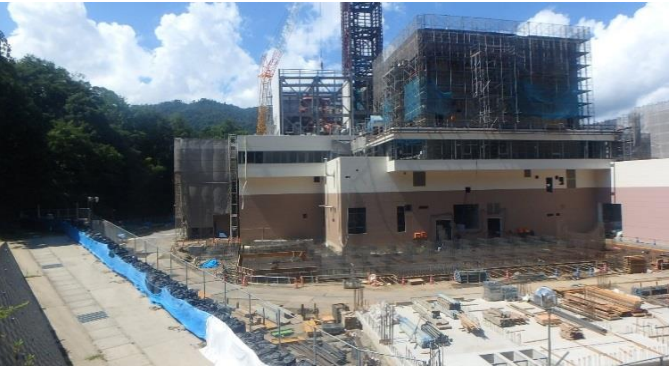
写真① 炉室・ごみピット・プラットフォームエリア(南角から)
