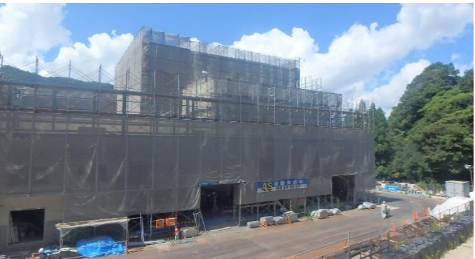
写真② プラットホーム・リサイクルエリア(南東から)
