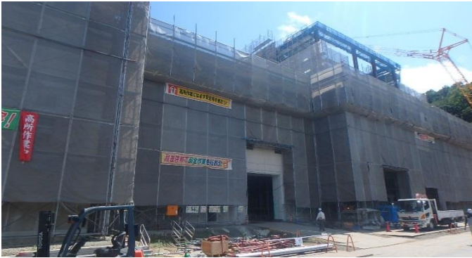
写真④ プラットホーム・ごみピット・炉室エリア(北西から)
