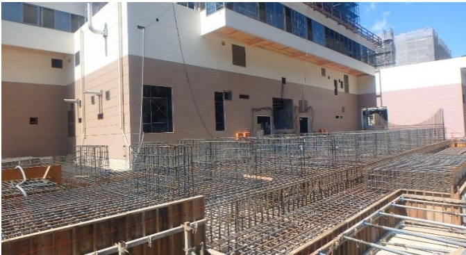
写真⑤ メタン発酵槽ガス貯留装置 基礎配筋
